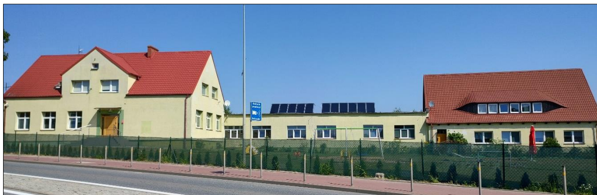
Rys. 66 Widok główny nieruchomości Przedszkola w Trąbkach Wielkich zarejestrowany z kierunku południowego.
