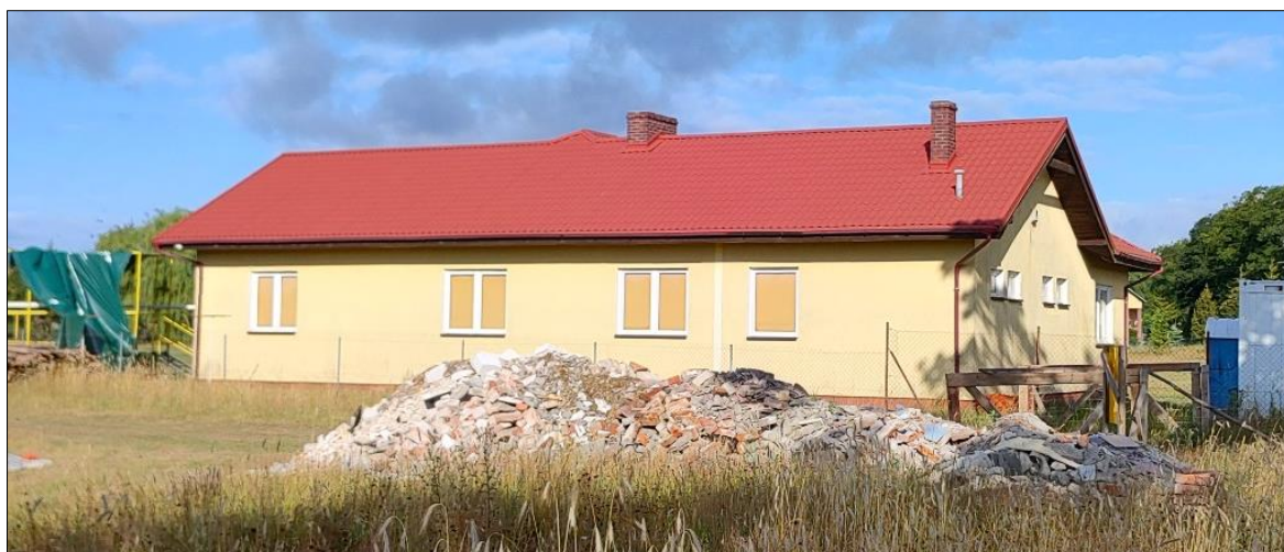
Rys. 14 Widok główny obiektu budowlanego Świetlicy Wiejskiej w Elganowie zarejestrowany z kierunku wschodniego.
