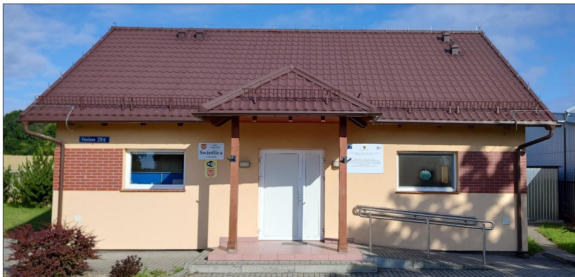
Rys. 50 Widok główny nieruchomości Świetlicy Wiejskiej w Pawłowie zarejestrowany z kierunku południowo-wschodniego.
