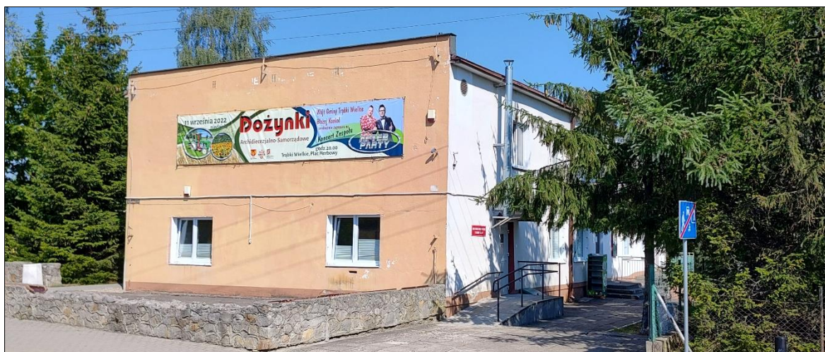
Rys. 54 Widok frontowy obiektu budowlanego GOKSIR w Trąbkach Wielkich zarejestrowany z kierunku południowego.
