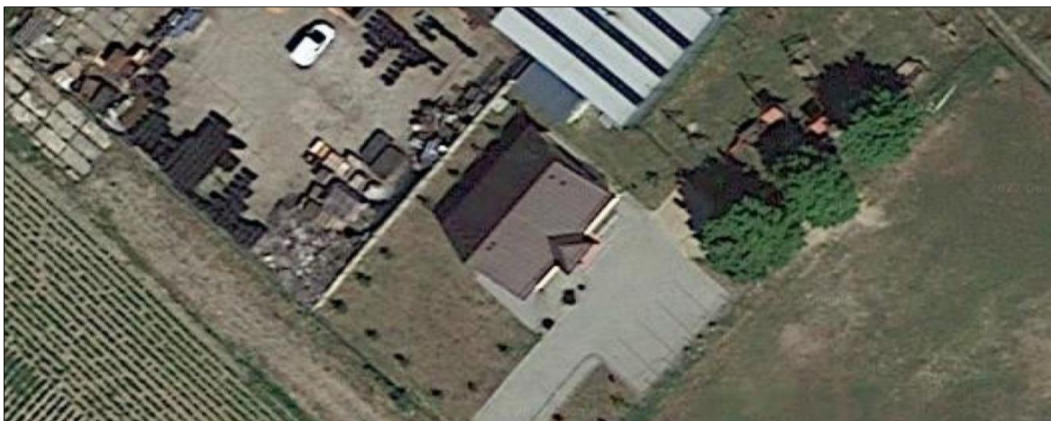
Rys. 51 Widok satelitalny połaci dachowych ŚW w Pawłowie predestynowanych do zabudowy modułami źródła energii.
