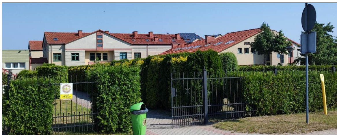
Rys. 78 Widok fasady frontowej nieruchomości SP w Trąbkach Wielkich zarejestrowany z kierunku południowego.
