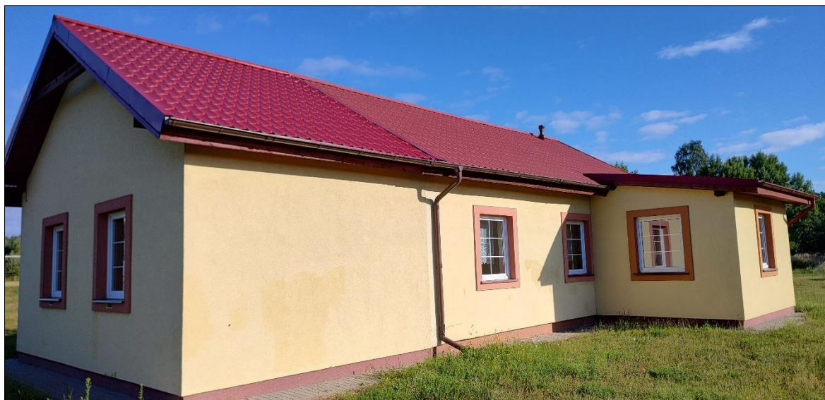
Rys. 22 Widok główny obiektu Świetlicy Wiejskiej w Gołębiewie Średnim zarejestrowany z kierunku południowego.
