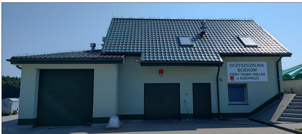
Rys. 58 Widok główny obiektu budowlanego Oczyszczalni Ścieków w Sobowidzu zarejestrowany z kierunku zachodniego.
