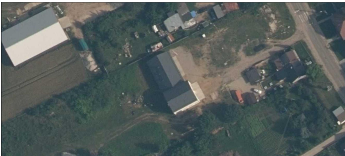
Rys. 43 Widok satelitarny połaci dachowej budynku OSP w Mierzeszynie predestynowanej do zabudowy modułami źródła.
