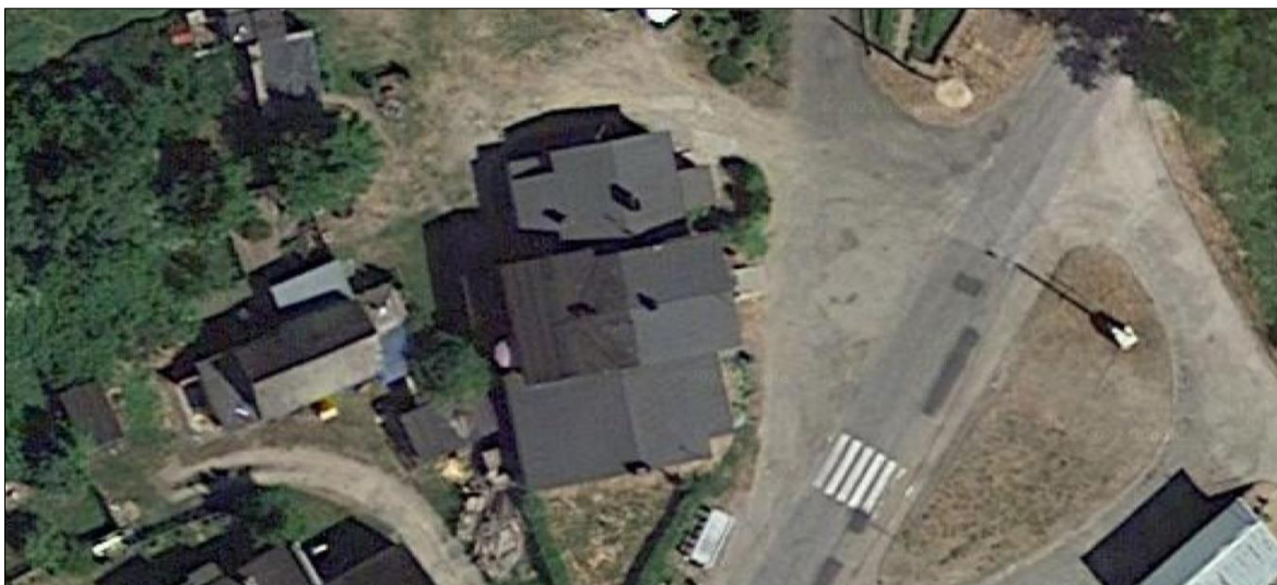
Rys. 31 Widok satelitalny połaci dachowej ŚW w Granicznej Wsi predestynowanych do zabudowy modułami fotowoltaicznymi.
