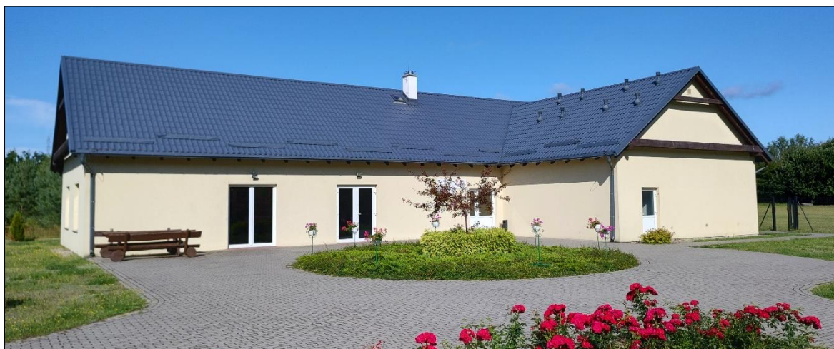
Rys. 10 Widok fasady obiektu budowlanego Świetlicy Wiejskiej w Domachowie zarejestrowany z kierunku wschodniego.
