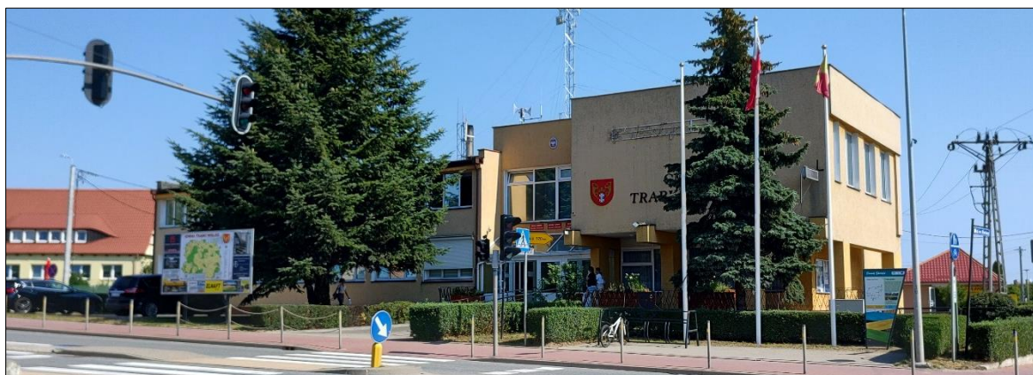
Rys. 6 Widok obiektu budowlanego Urzędu Gminy Trąbki Wielkie zarejestrowany z kierunku południowo-zachodniego.
