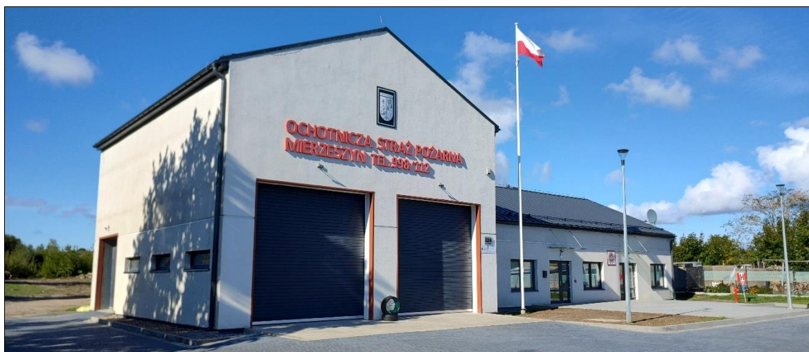
Rys. 42 Widok obiektu budowlanego Ochotniczej Straży Pożarnej w Mierzeszynie zarejestrowany z południowego wschodu.
