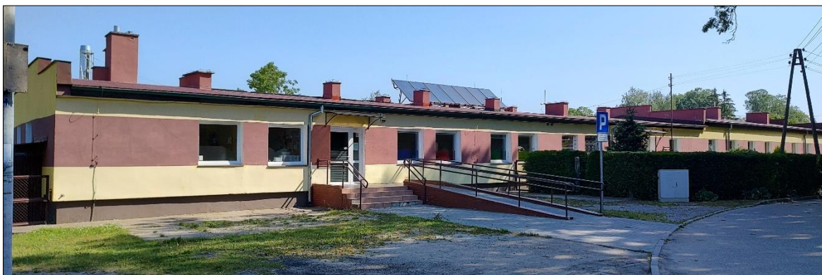
Rys. 82 Widok fasady frontowej nieruchomości Przedszkola w Trąbkach Wielkich zarejestrowany z kierunku południowego.
