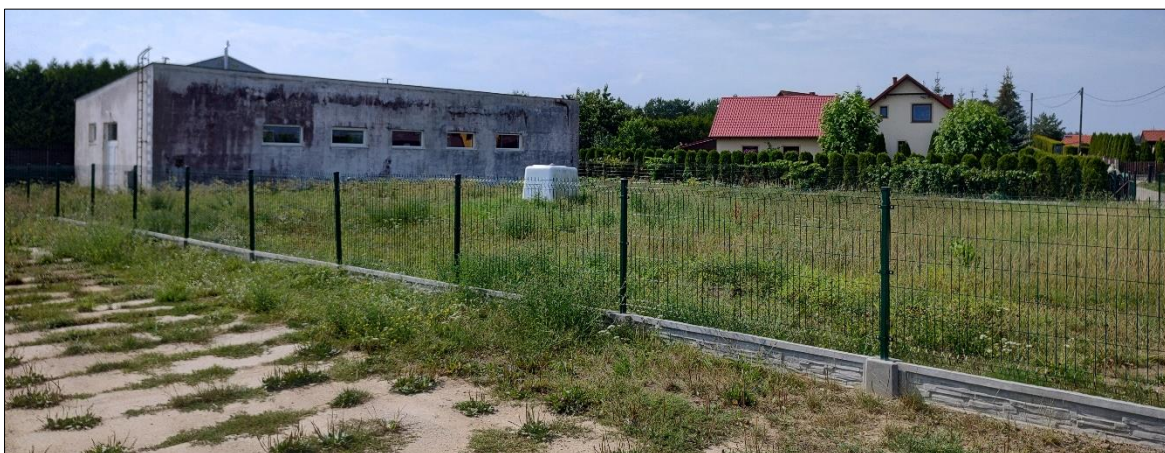
Rys. 100 Widok lokalny obiektu Hydroforni w Trąbkach Małych zarejestrowany z kierunku północno-wschodniego.
