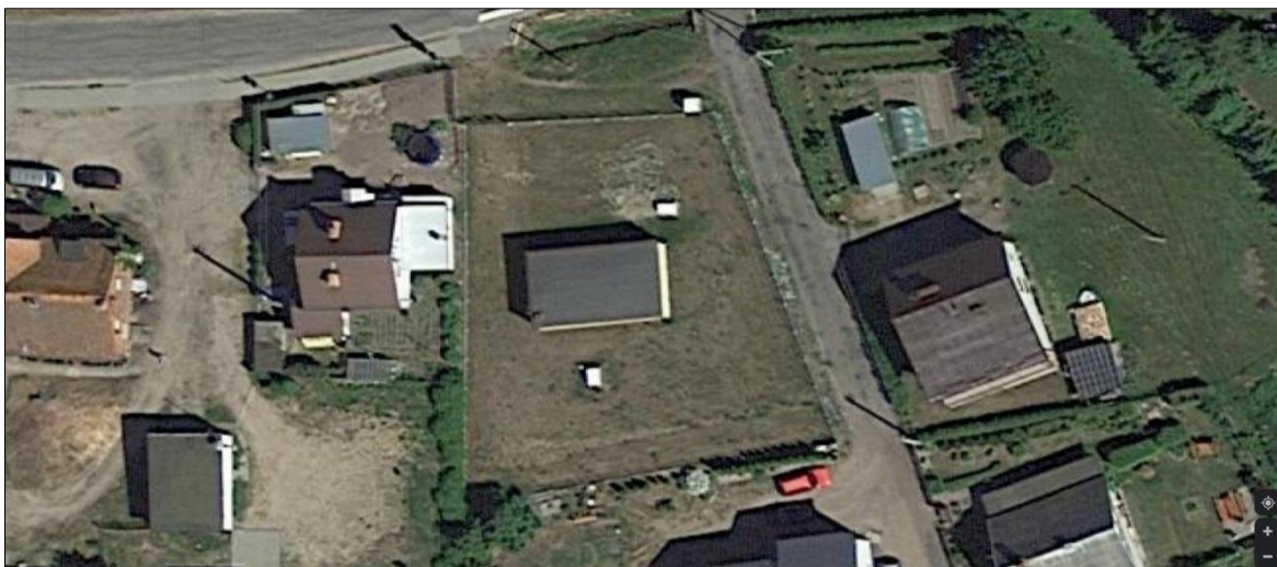
Rys. 93 Widok satelitalny połaci dachowych Hydroforni w Elganowie predestynowanych do zabudowy modułami źródła.
